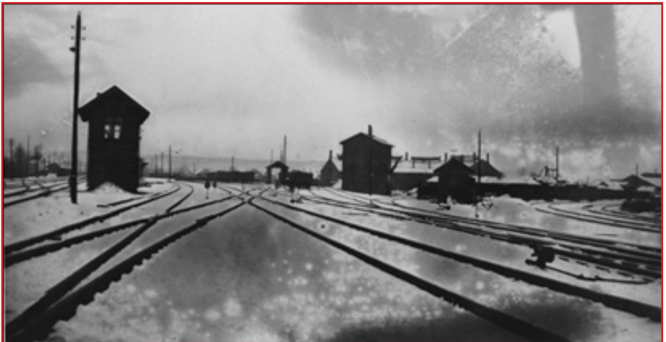
Huset til venstre er stillverket ved Lillestrøm stasjon, 1920.
