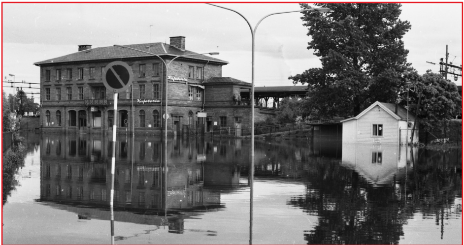
Oversvømmelse ved Lillestrøm stasjon, 1967. Foto: NVE/Edvigs Kanavin
