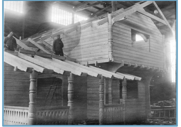
Laftehus under montering i tømmermannshallen. Foto: Akershusbasen
