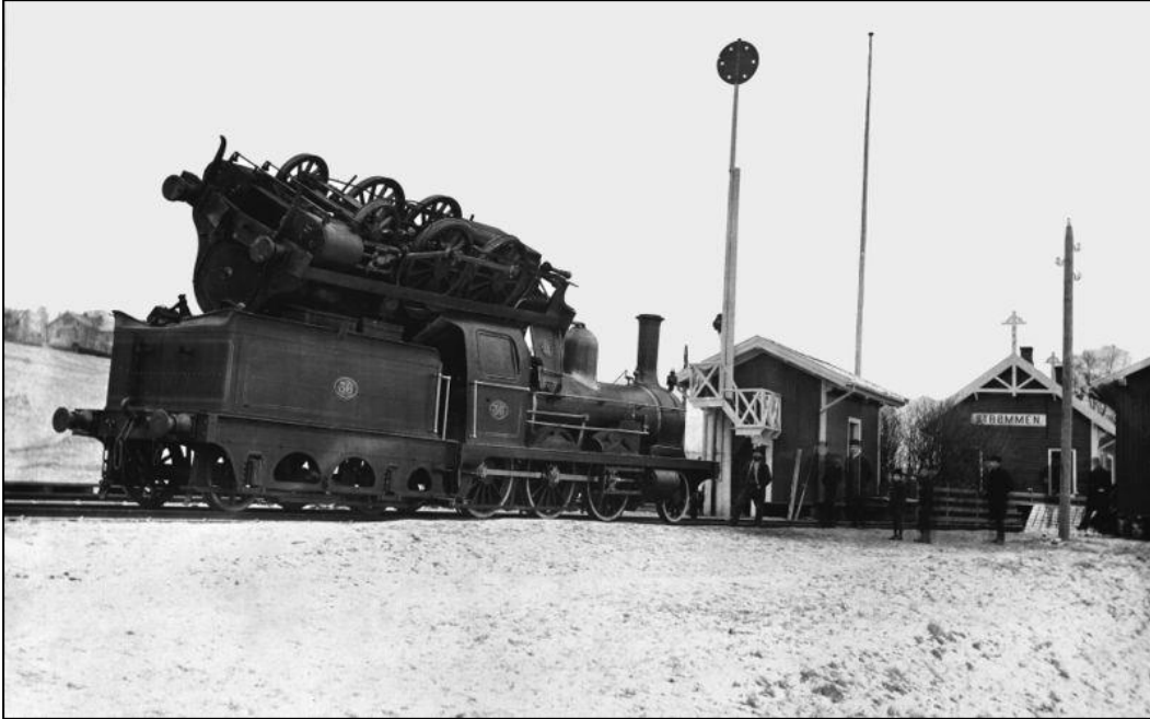
Lokomotiv nr. 11 ligger oppå nr. 3 etter at kjelen eksploderte. Foto: Ukjent/Jernbanemuseet
