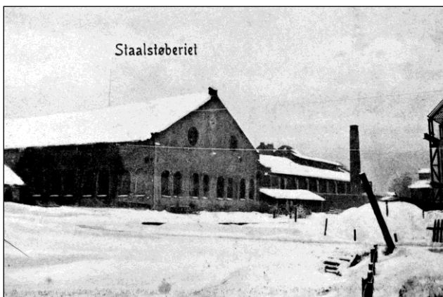
Et gammelt postkort viser stålstøperiet i 1910. Foto: AFM 0231-112:0076
